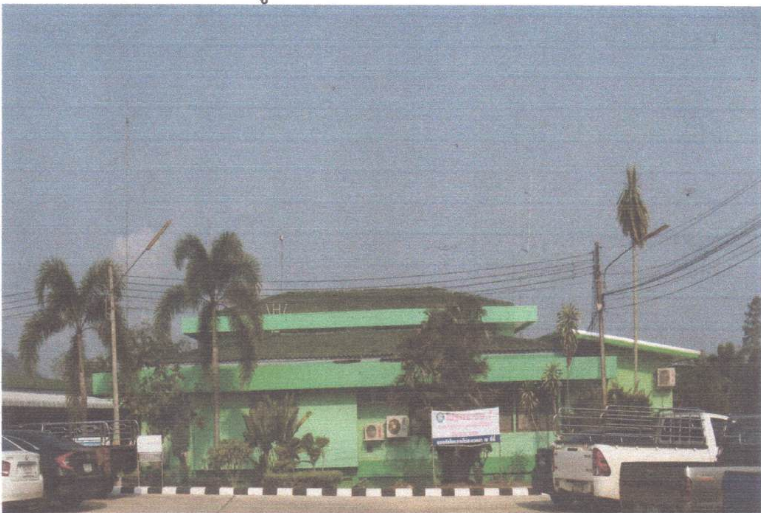
หมายเหตุ ดำเนินการเปลี่ยนหลังคาเป็นเมทัลชีท ณ วันที่ 17 เม.ย.67
